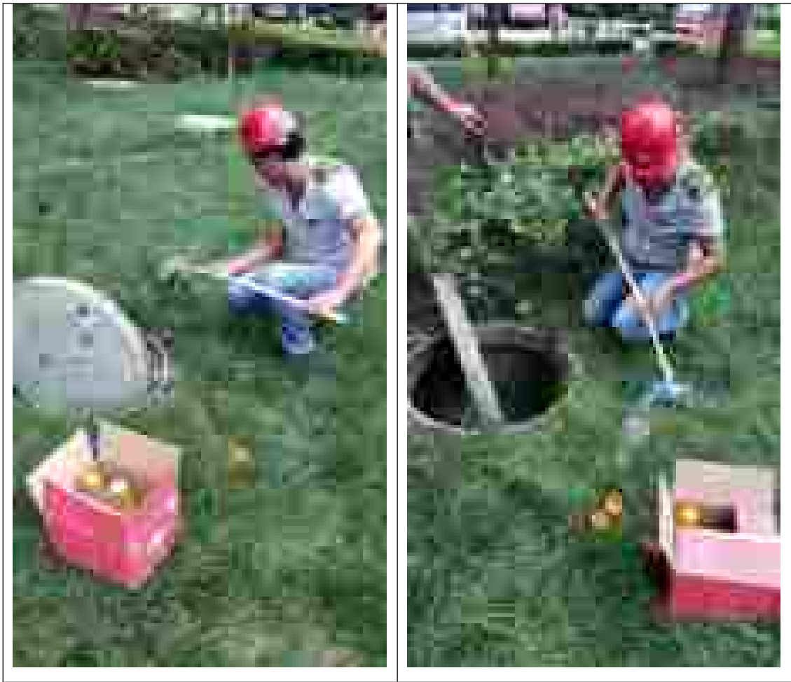
附图 4：现场检测图片
